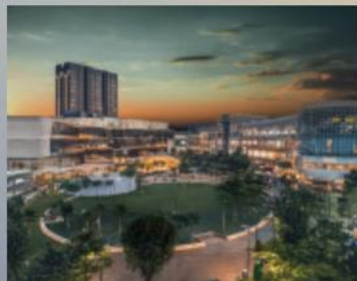
BINTARO JAYA XCHANGE MALL TAHAP 2
