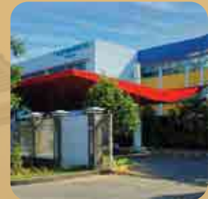
SEKOLAH PEMBANGUNAN JAYA
