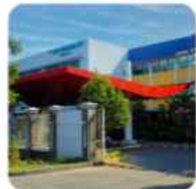
SEKOLAH PEMBANGUNAN JAYA
