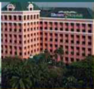
Rumah Sakit Siloam Hospital
