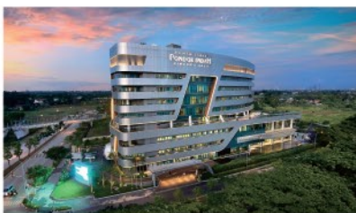
RUMAH SAKIT PONDOK INDAH BINTARO
