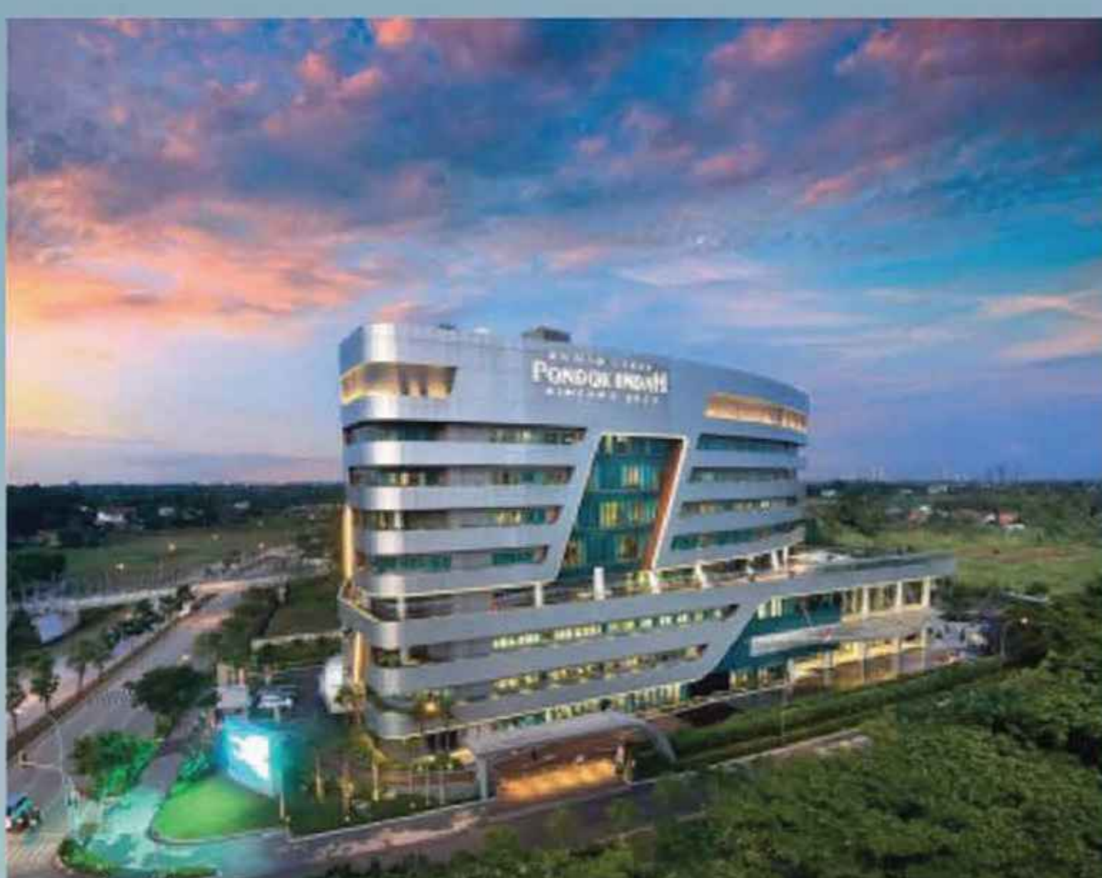
RUMAH SAKIT PONDOK INDAH BINTARO
